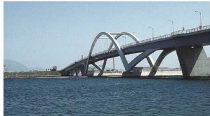
海の中道大橋(福岡市東区)
